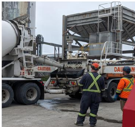
Concrete Pour - fill in steel piles and cap-off top.
